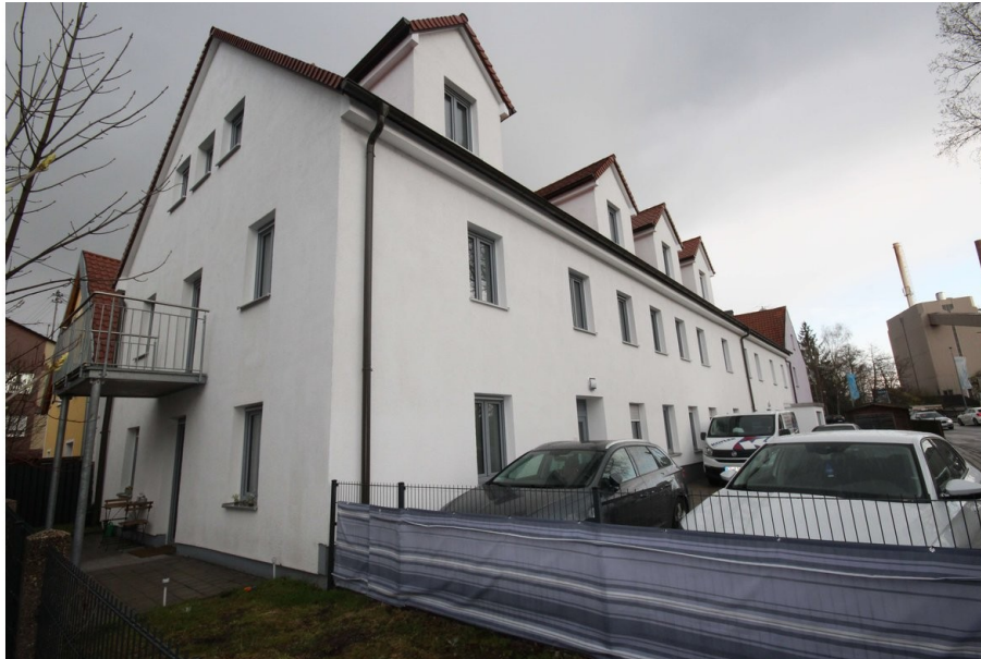
Vorderansicht der Wohnanlage
