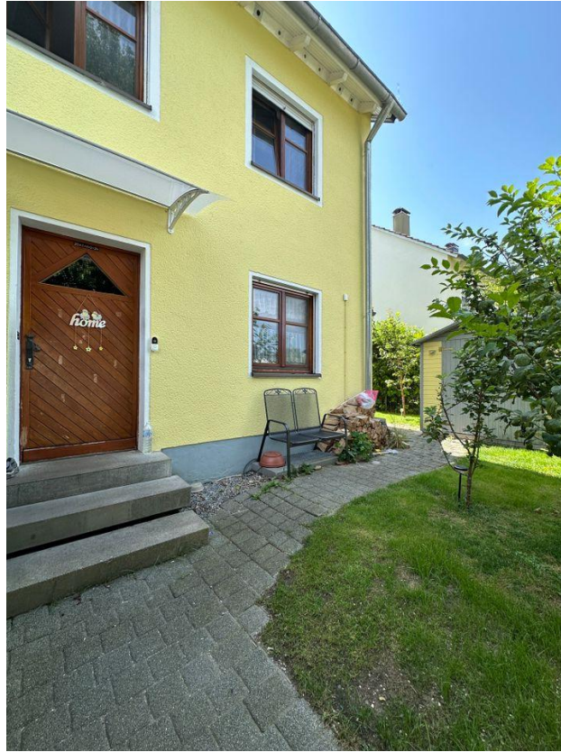
Zugang zum Haus
