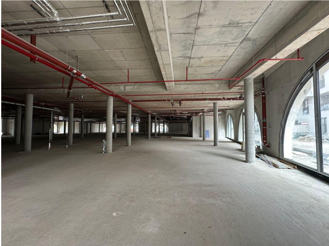
Innenansicht im Rohbau
